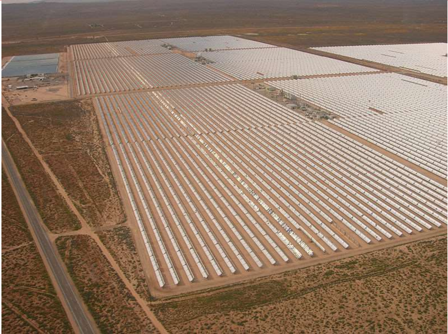
Centrale solaire en Californie
