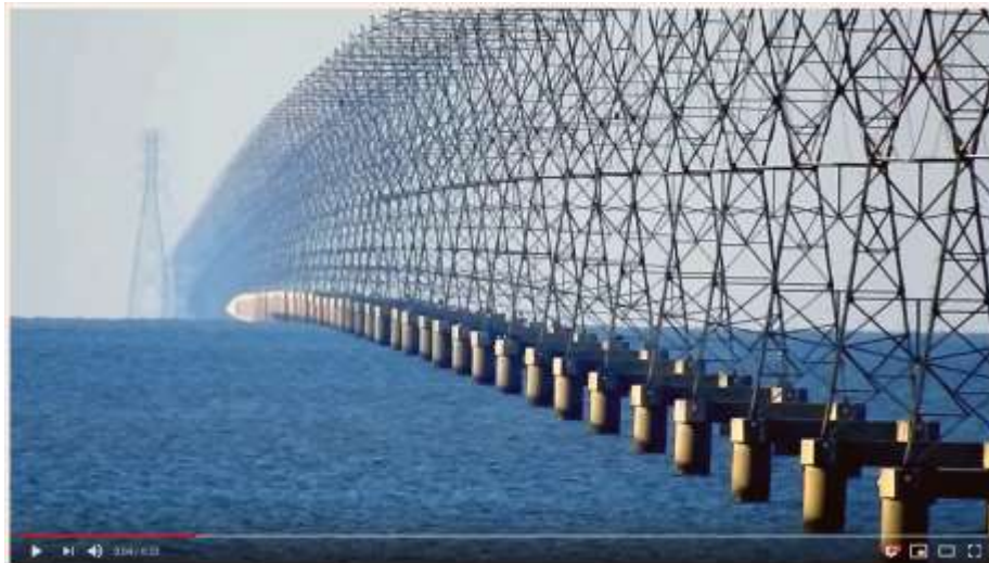
Ligne électrique sur le Lac Pontchartrain, Louisiane
